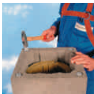
22. Slå i fästpluggarna för kronan i armeringshålen på manteln och montera kronan med medföljande skruv.
