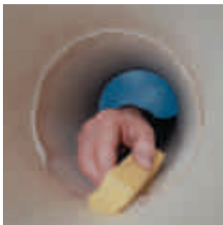
20. Stryk ut överflödig fogmassa.
