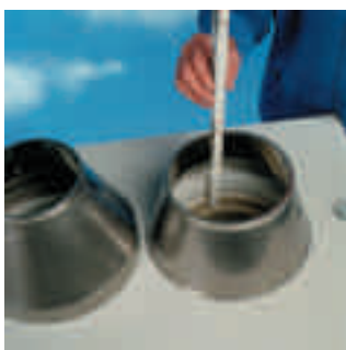
23. Ställ toppavslutningen på kronan och mät avståndet mellan foderröret och toppen på toppavslutningen. Kapa ett foderrör så att det går ända upp till toppen av toppanslutningen.
