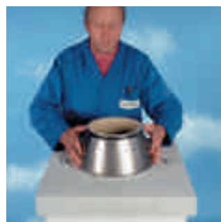
24. Montera det sista foderröret och tryck fast toppavslutningen på foderröret.
